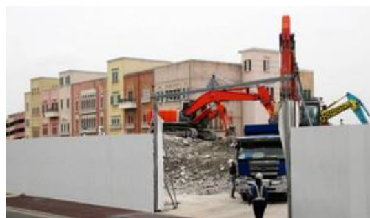
解体進む 20 号倉庫と解体を待つ 4 号倉庫
